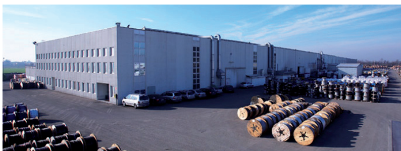
Fábrica cables de media tensión en Argentina (ITA)
